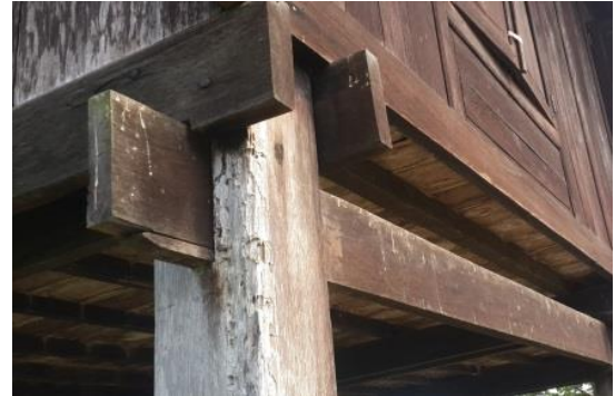
Gambar 5. Konstruksi Pattolo dan Arateng pada rumah saoraja lapinceng
