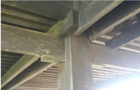
Gambar 5. Konstruksi Pattolo dan Arateng pada rumah saoraja lapinceng
